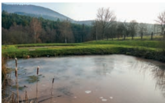
Bassin de décantation - St Pierre Bois
